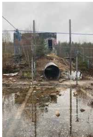
SK16 vörn vid Kranhults bro.
